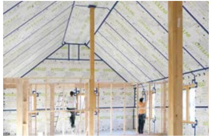
Abb. 7: Messzeitpunkt: Nach Fertigstellung der Luftdichtheitsebene im Zuge der Gewerkeabnahme. Bild: Moll pro clima
