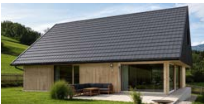
Abb. 18: Beispiel eines Daches in gemäßigter Lage, bei dem die Mindestanforderung nach Tab. 21 ausreicht. Bild: Wienerberger
