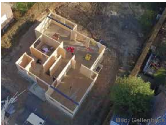
Abb. 7 Bautenstand am Morgen, die EG-Wände sind montiert.
