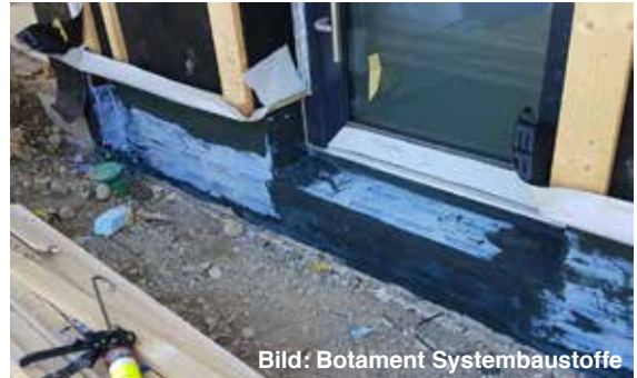
Abb. 65 Um eine dauerhafte dichte Abdichtung am Sockel herzustellen, braucht es ein für diese Verwendung konzipiertes System. Eine Lösung gerade wegen der komplexen Untergründe sind die modernen „reaktiven“ FPD-Abdichtungen.
