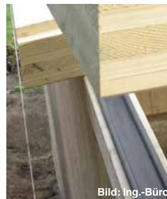
Abb. 60 Beim Aufsetzen der Deckenelemente wird die Luftdichtung durch das Einlegen eines speziellen Dichtungsprofils vorbereitet.
