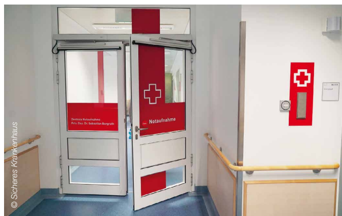
Türen eines Krankenhauses
